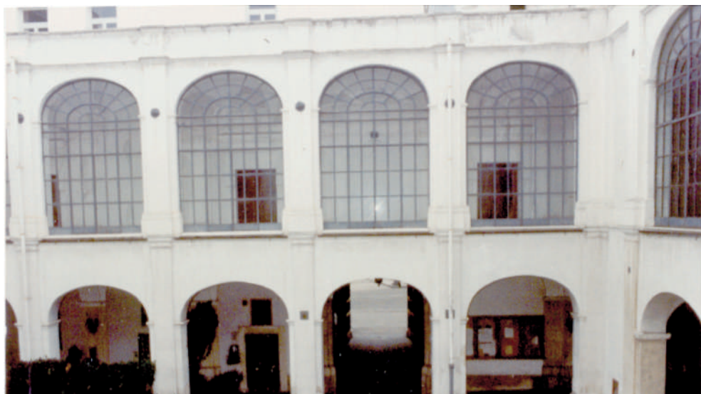
Figura 23 - Foggia, Palazzo Dogana: controfacciata dell'ingresso.
