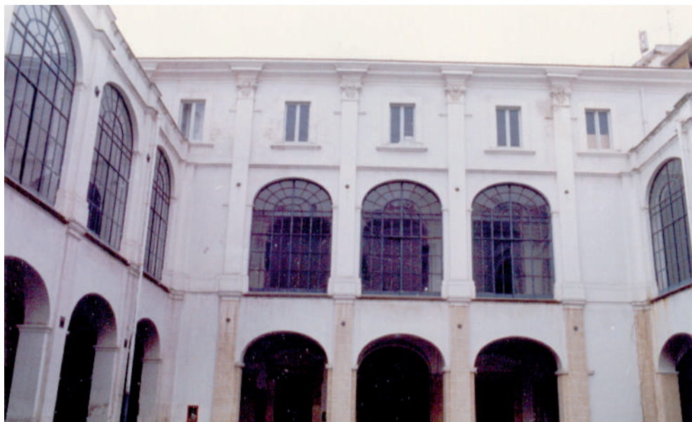
Figura 22 - Foggia, Palazzo Dogana: prospetto loggiato del cortile.
