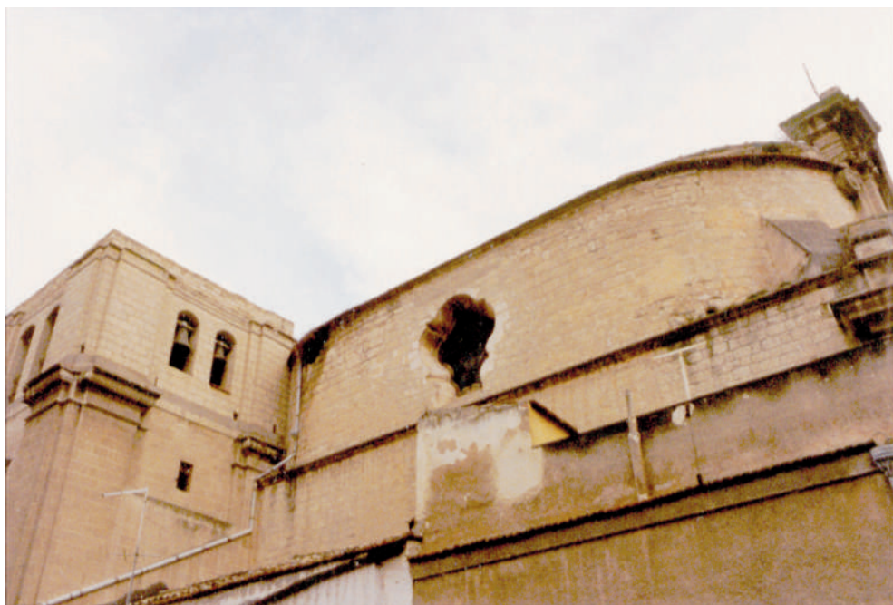
Figura 19 - Foggia, Addolorata: veduta esterna del tamburo della copertura.
